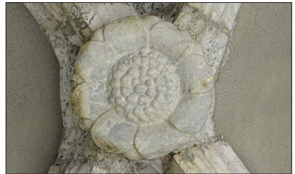
Clefs de voûtes de l'arcade Église Saint-Vincent, Bagnères-de-Bigorre
